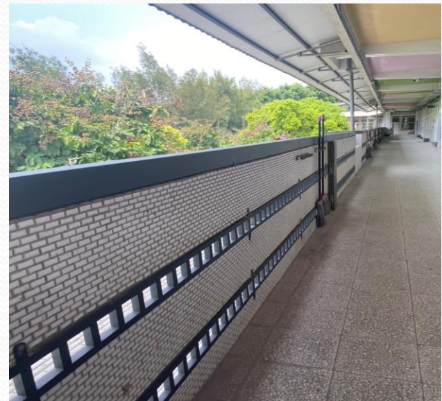
◎圍牆封閉孔洞
