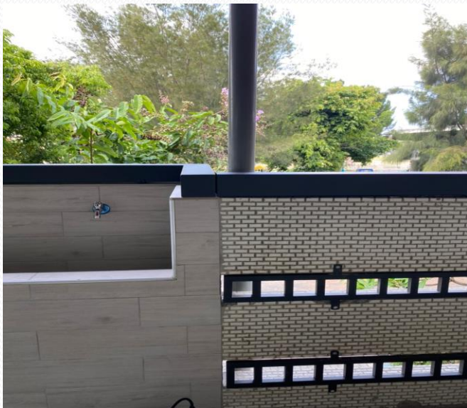
◎勤學樓二樓圍牆加高欄杆
