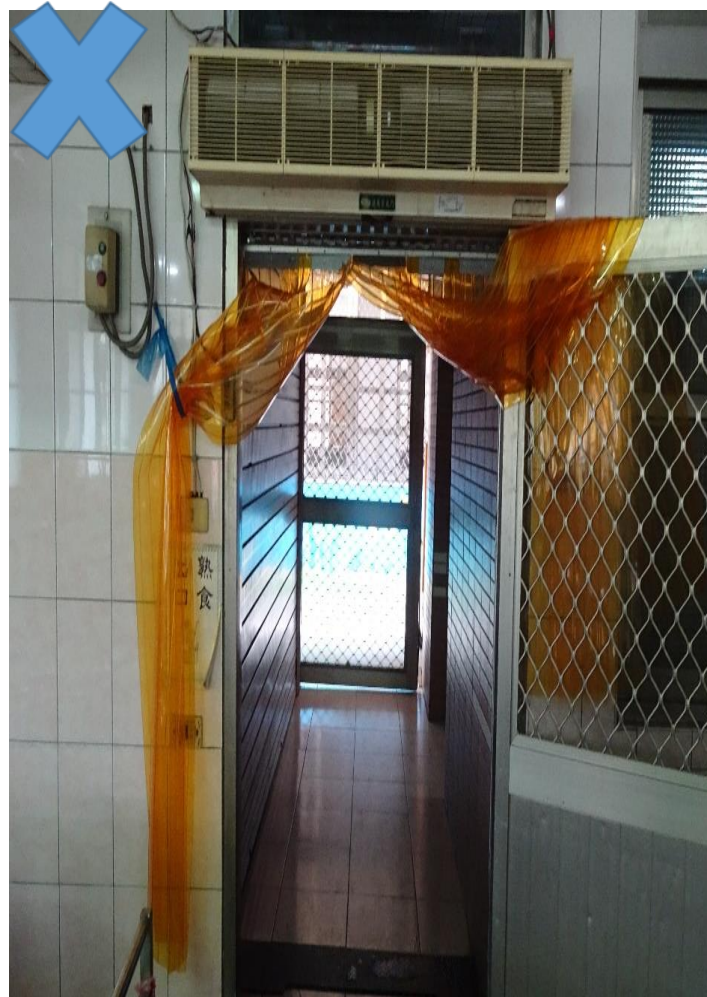
作業中出入口防蟲簾未正確使用
